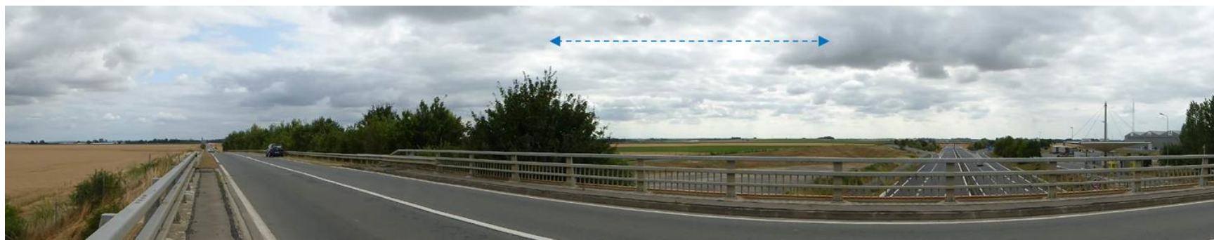
Figure 172 : photo 31 - RD 937 au sud de la Croix Maligneaux et en amont de l'église St-Médard (MH 10), les éoliennes existantes sont visibles au loin.
